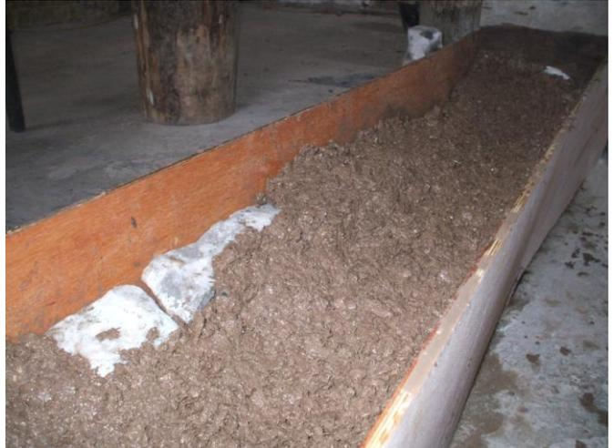
Se vuelca dentro de un encofrado construido con placa fenólica de 10 mm, permitiendo realizar planos de doble curvatura. La carga se aplasta levemente con una llana. El tiempo de secado ronda las 4 semanas en espesores de 40 cm en muros, aunque el desencofrado puede hacerse en 3 o 4 días.
